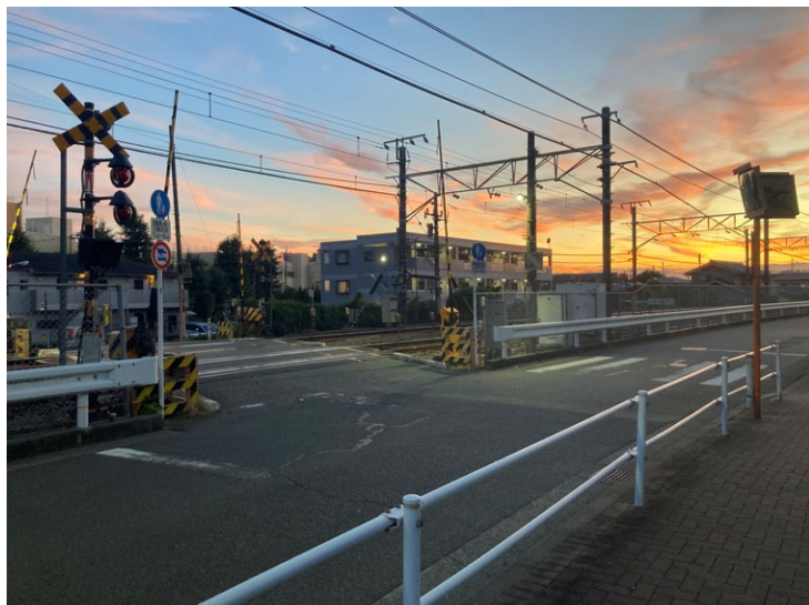
[写真 5] 六小東門側踏切付近
